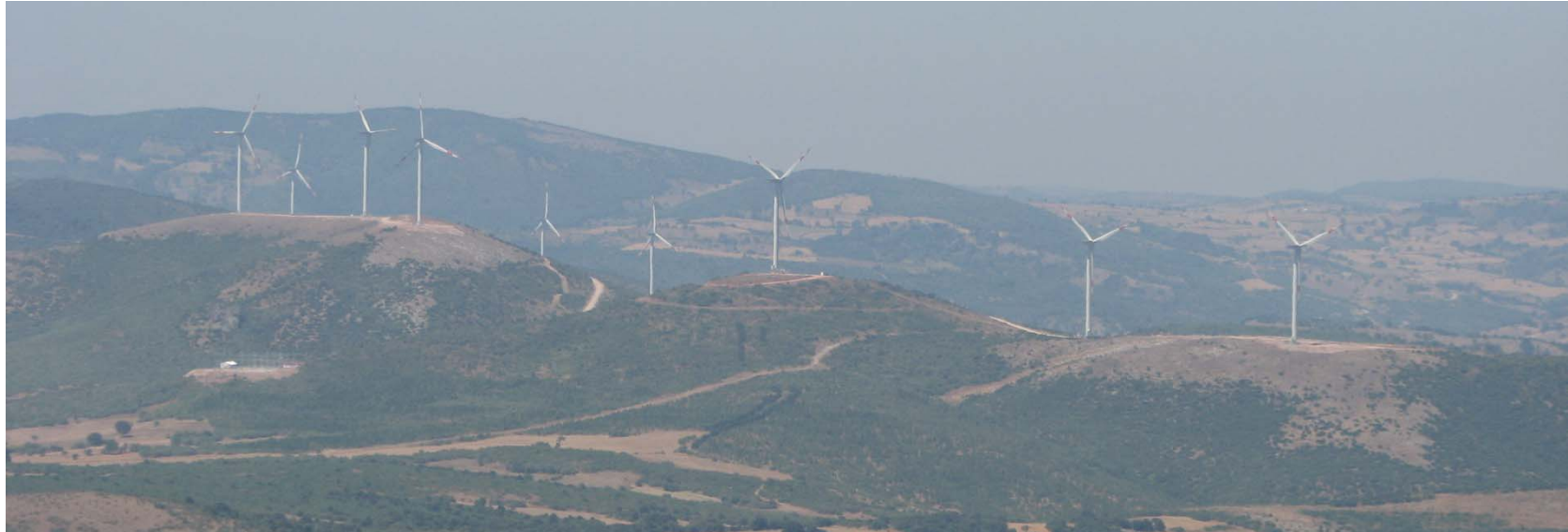
Şekil 4-2 Proje Sahasından Susurluk RES'in Yakından Görünüşü (T13'den)
