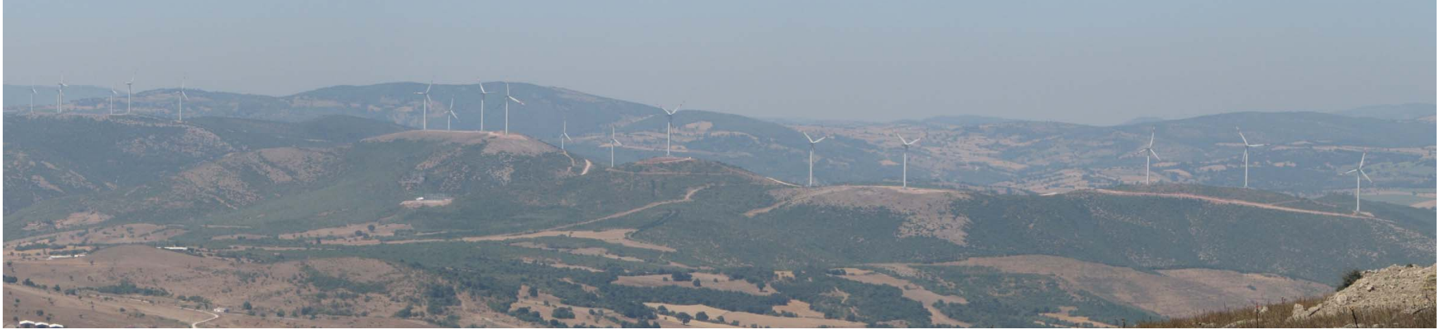
Şekil 4-1 Proje Sahasından Susurluk RES'in Görünüşü (T13'den)
