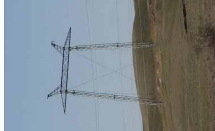
Üçqat 4 əlaqə nöqtəsi olan polad-tor konstruksiyalı qüllələr. Əsasən istiqamətlərin dəyişdirilməsi zamanı və yüksək stress vəziyyətlərində istifadə olunur.
