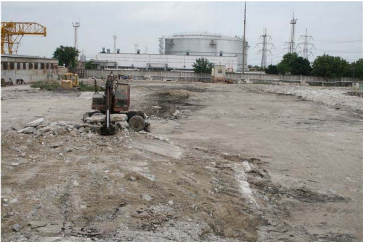
Рис. 3. Современное состояние участка под строительство ПГУ-410
