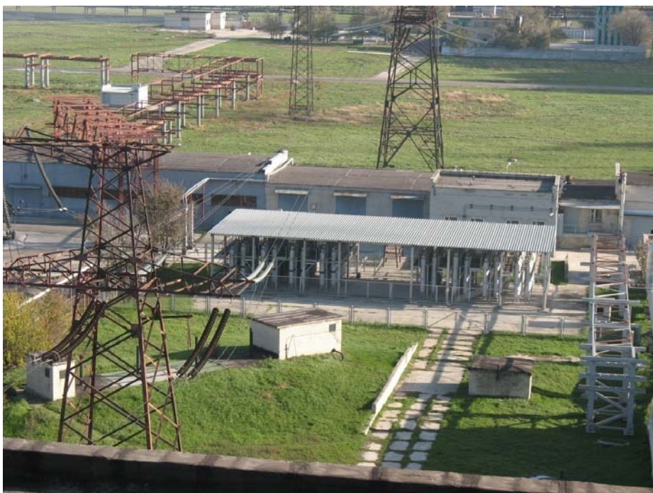
Рис. 4. Азотно-кислородная станция (открытая компоновка реципиентов)
