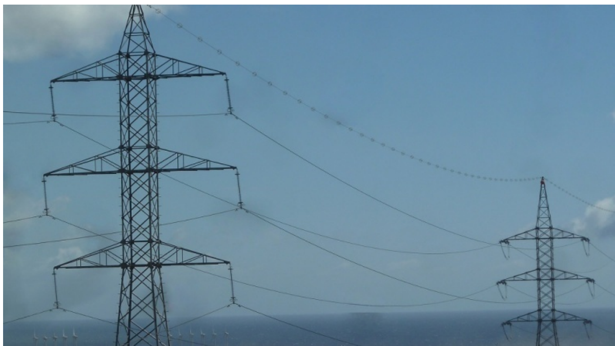
Figure 5-3. Des exemples de marqueurs/dispositifs de déviation pour les oiseaux installés en Espagne.
