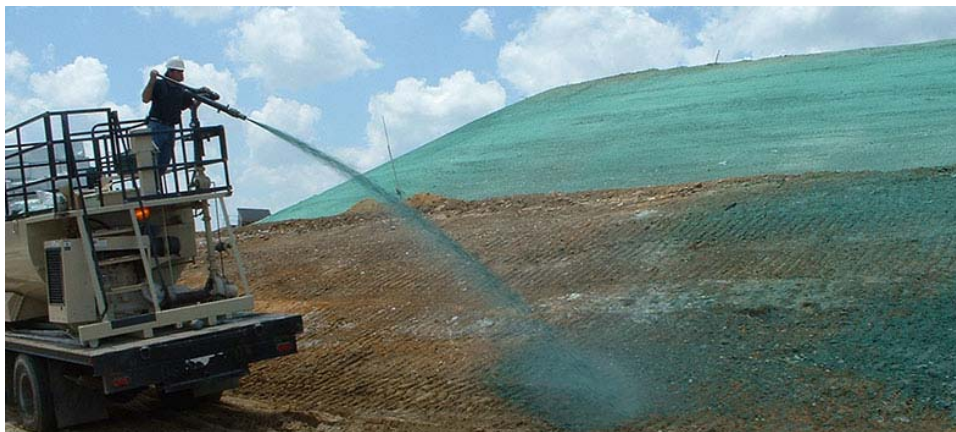
Slika 11: Primer hidrosejanja koje se primenjuje za aktivnosti vraćanja u prethodno stanje
