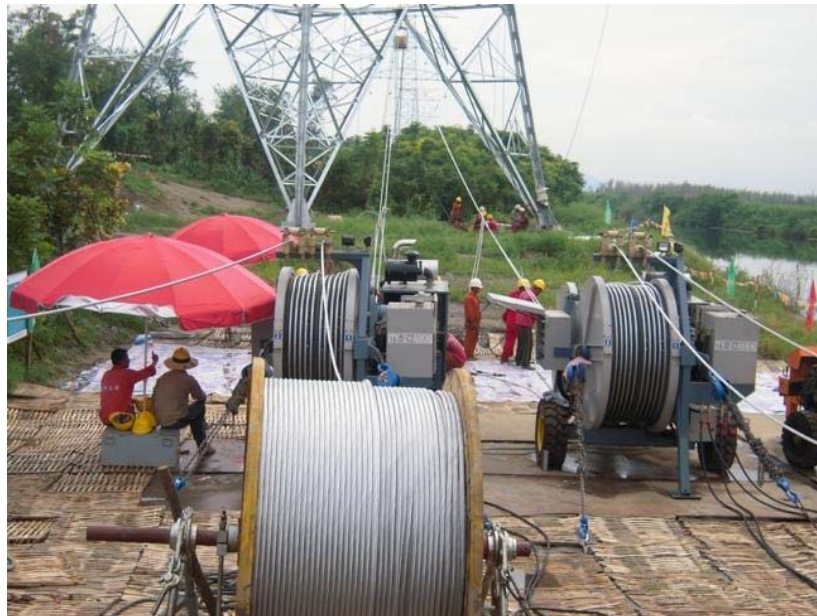
Slika 6: Postavljanje kablova za linije električnog voda
