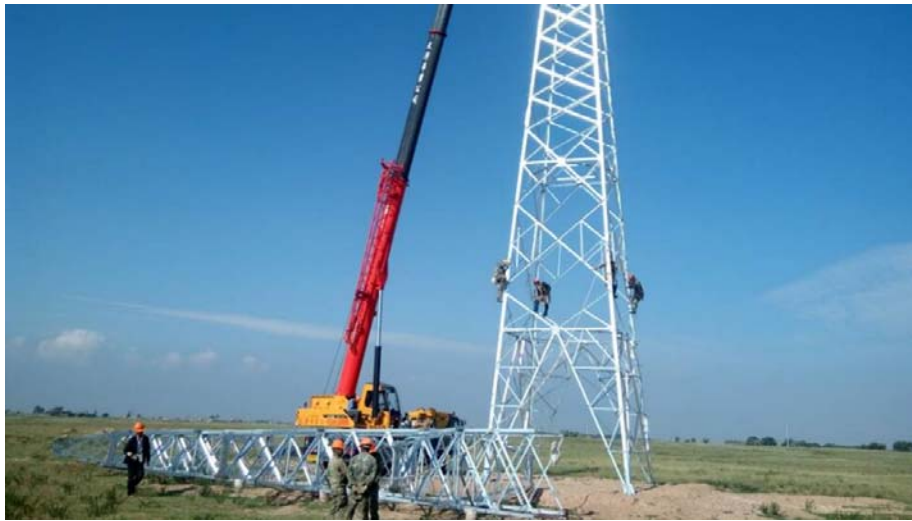
Slika 5: Postavljanje pilona od 110 kV
