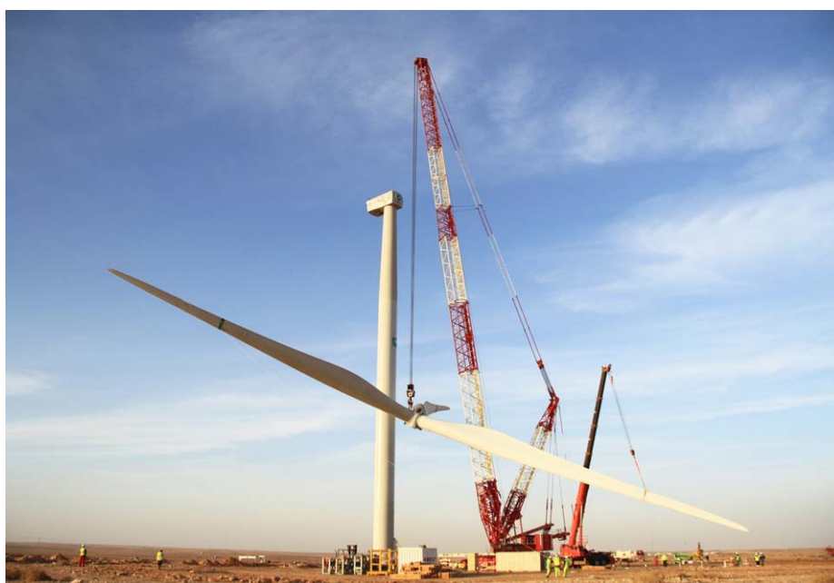
Slika 10: Sklapanje kule vetroturbine
