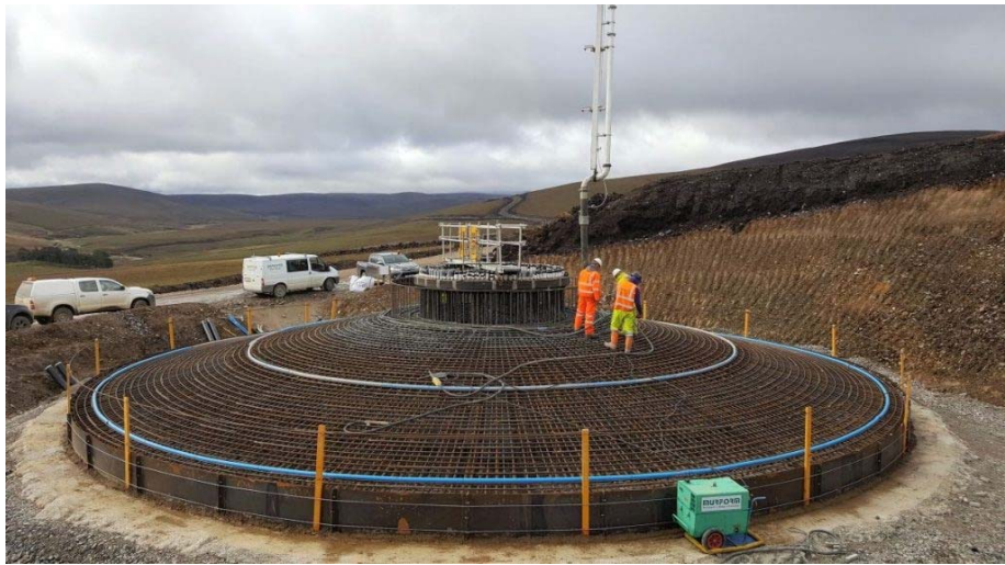
Slika 7: Izgradnja temelja za vetroturbinu
