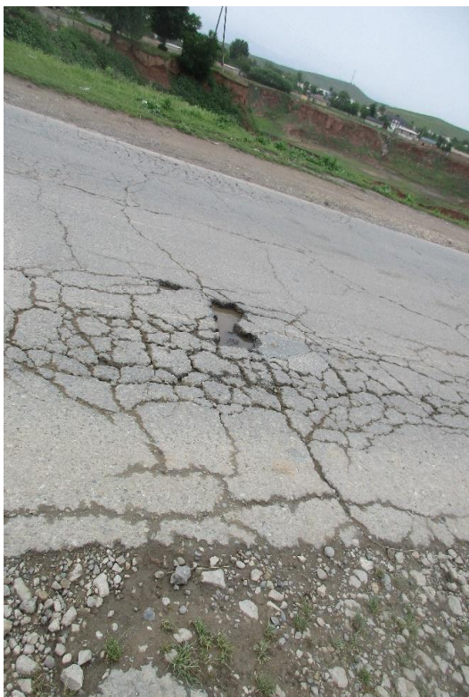
Рисунок 5 - Сильно поврежденное дорожное покрытие (фото сделано 30.04.2024)
