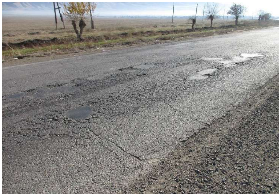
Рисунок 6 - Сильно поврежденное дорожное покрытие (ноябрь 2021 г. 17+600 км)
