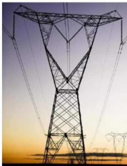
Рисунок 48: Самонесущая стальная решетчатая промежуточная опора 500 кВ (одноконтурная) (источник: НЭСУ)
