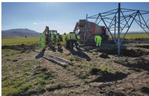
Рисунок 58: Пример конструкции фундамента опоры (источник: NJDA, 2022)
