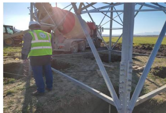
Рисунок 59: Пример конструкции фундамента опоры (источник: NJDA, 2022)
