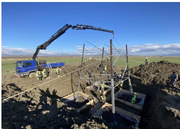
Рисунок 60: Пример процесса сборки опоры (источник: NJDA 2022)
