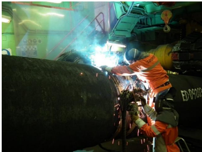
Σχήμα 2-45: Συγκόλληση αγωγού στη Φορτηγίδα εφαρμογής της μεθόδου S-Lay
