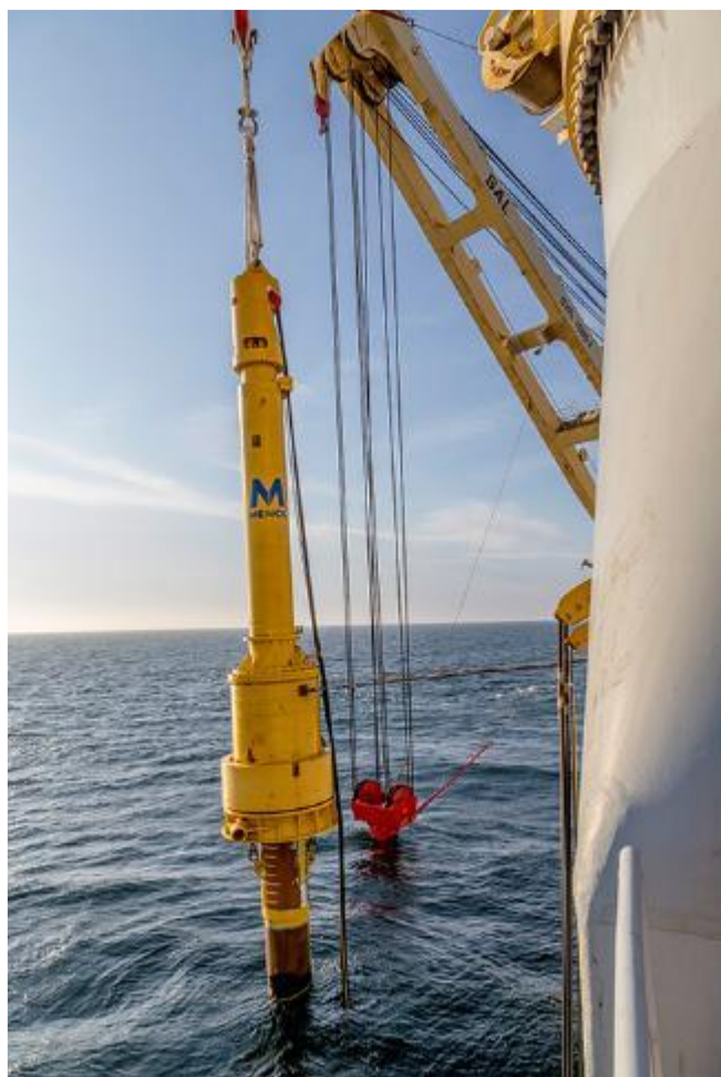
Σχήμα 3–21: Κρουστικός μηχανισμός οδήγησης κατά τη λειτουργία του
