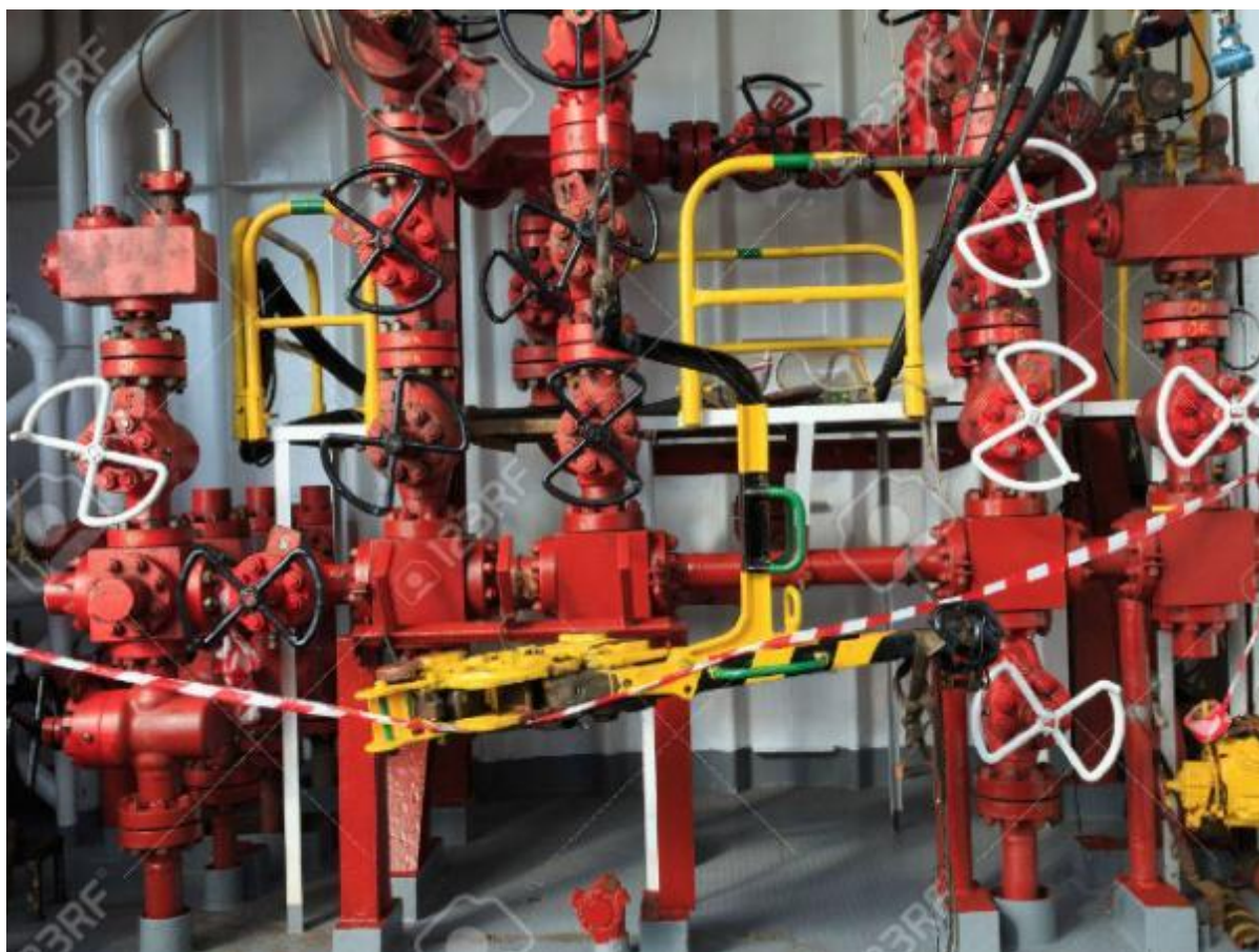
Σχήμα 3-26: Τυπικό σύστημα BOP σε γεωτρύπανο τύπου Jack up
