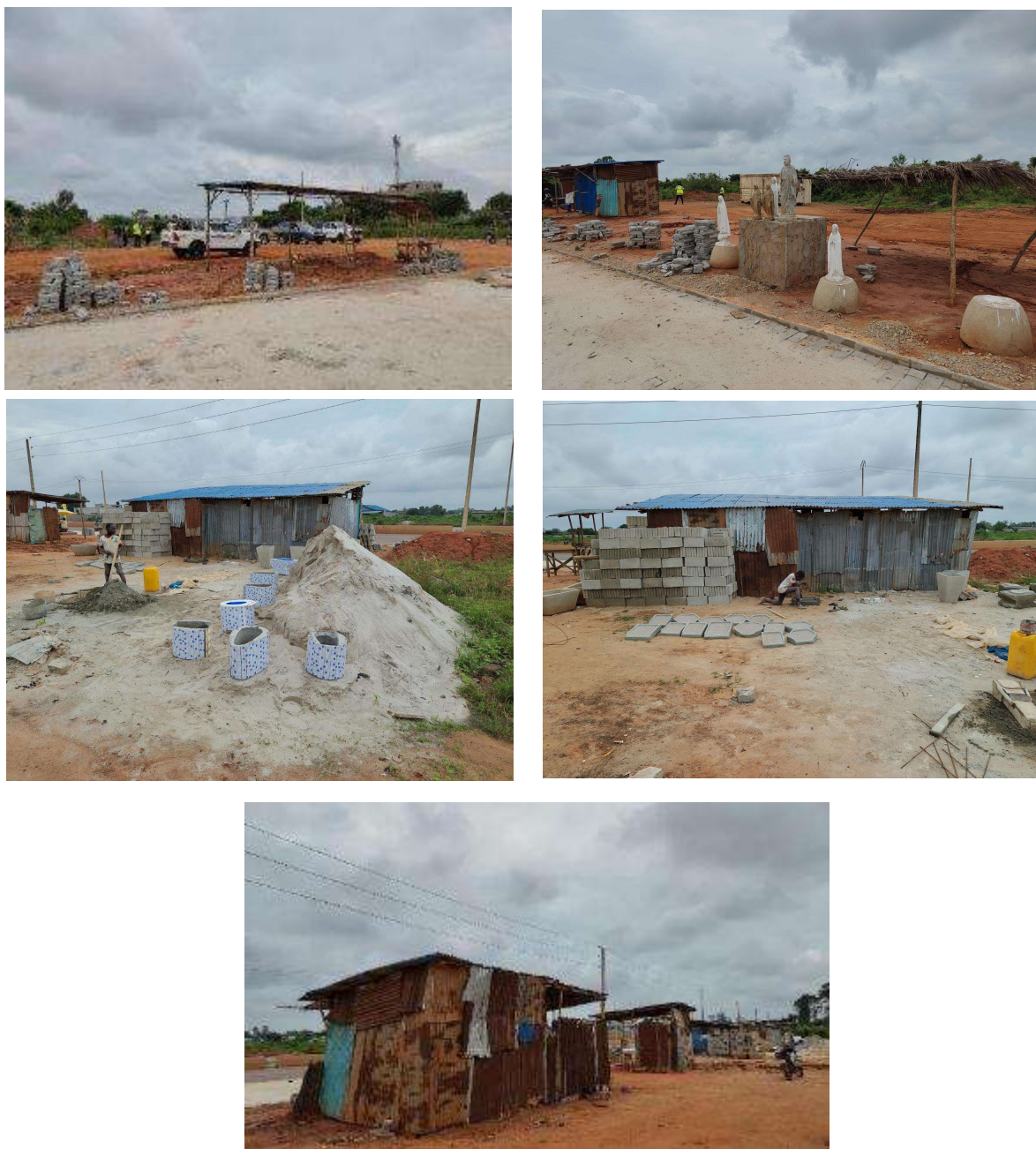
Figure 4 - Photographies du site communal à Ouédo, commune d'Abomey-Calavi (Source : GWCC, 2025)
