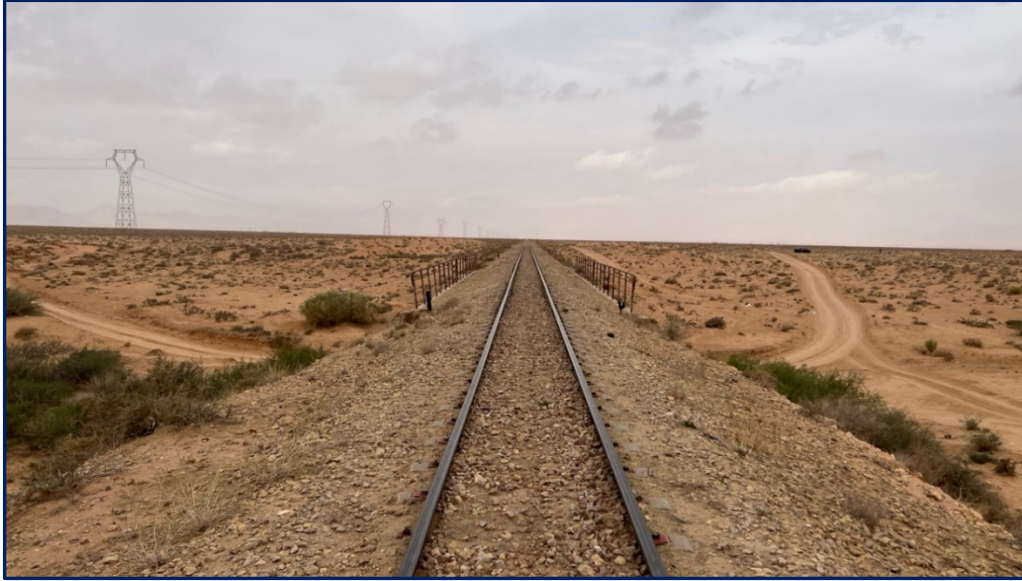
الشكل 3: خط الكهرباء عالي الجهد بوشمة - المظيلة (150 كيلو فولت) والسكة الحديدية الواقعة جنوب محطة الطاقة الشمسية الكهروضوئية
