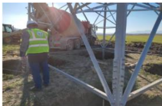
Рисунок 41: Пример процесса монтажа опоры (источник: http://cscon.co.za/ and EDM)
