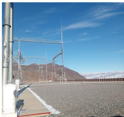
Рисунок 9: Резервная ячейка для ВЛЭП 500 кВ «Кемин-Балыкчы» на подстанции «Кемин» (источник: первоначальный отчет «Кемин-Балыкчы», декабрь 2024)
