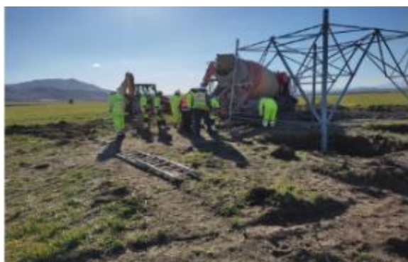
Рисунок 40: Пример процесса монтажа опоры (источник: NJDA 2022)
