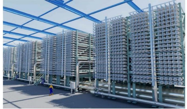
الشكل 15 رسم توضيحي لمبدأ التناضح العكسي ووحدات التناضح العكسي في محطة التحلية
