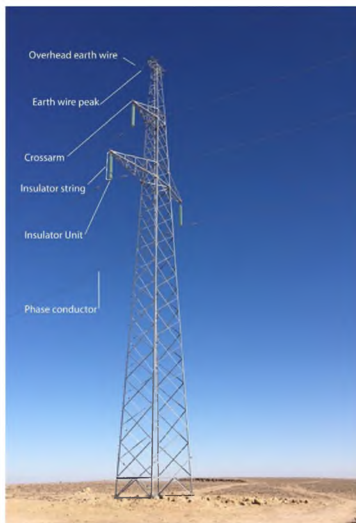
Figure 6: Yuqori kuchlanishli havo tarmog'i komponentlari (manba: Juru energiyasi)
