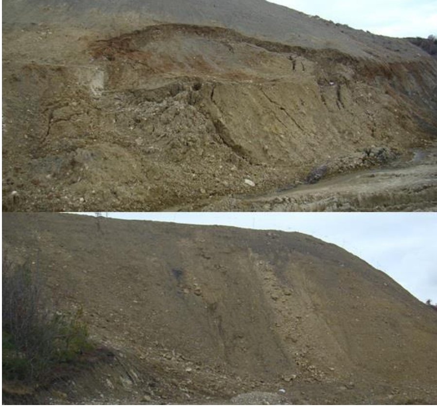
Şekil 6-15: GBP Şantiye Alanındaki Yar Şevlerindeki Bazı Kitlesel Hareketler (düşme, kayma ve akış)
