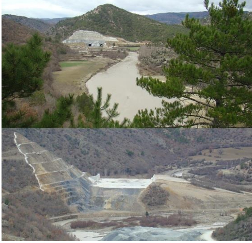
Şekil 6-7: GBP Maden Sahası Şantiyesi Derivasyon tüneli (üstte) ve Dolusavak (altta) İnşaatı
