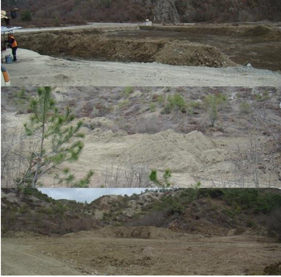
Şekil 6-12: GBP Şantiyesinde Üst Toprak Yönetimi
