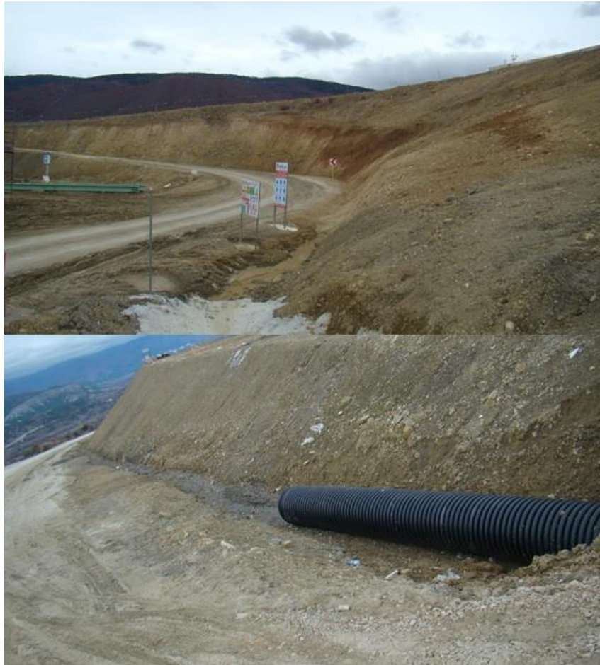
Şekil 6-10: Erişim Yolu Yolları Boyunca Topuk Hendeği İçerisindeki Çökeltilerin Gelişimi
