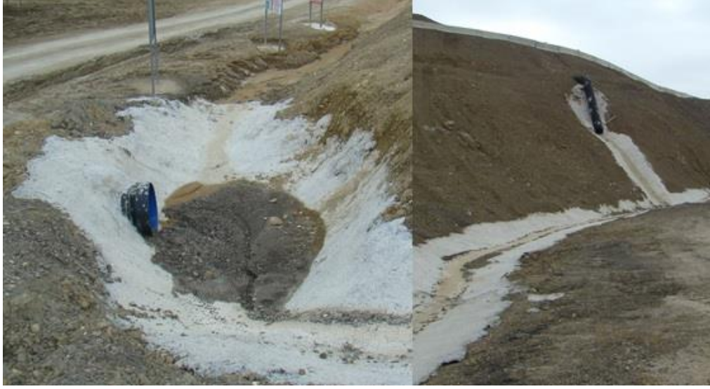
Şekil 6-9: Menfez ve Topuk Hendeği (bir yol kavşağına ve erişim yolu yarı boyunca inşa edilmiş)
