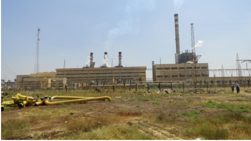
صورة 5-1: المنظر العام في محيط محطة كهرباء دمنهور
