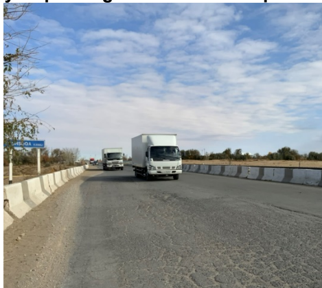
Rasm 10:Yo'l qoplamasidagi yoriqlar va g'ildirak izlari chuqurlari
