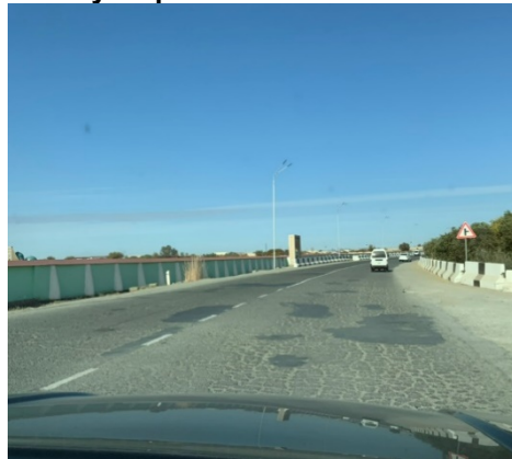
Rasm 11:Yo'l qoplamasidagi yoriqlar va ta'mirlashlar
