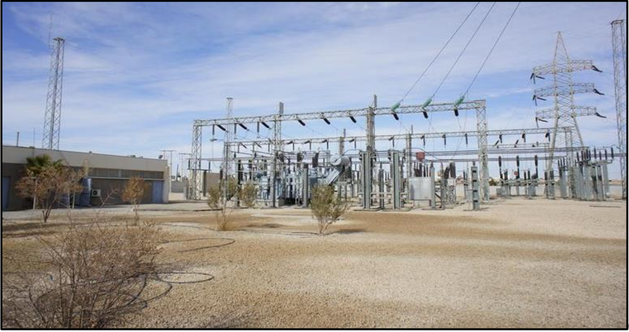
شكل 6: محطة تحويلية نموذجية بقدرة 220/33 كيلو فولت
