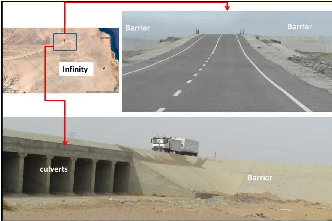
شكل 53: تُظهر الصور الميدانية الحاجز المائي عند الكيلومتر 8 والقنوات المرتبطة به.
