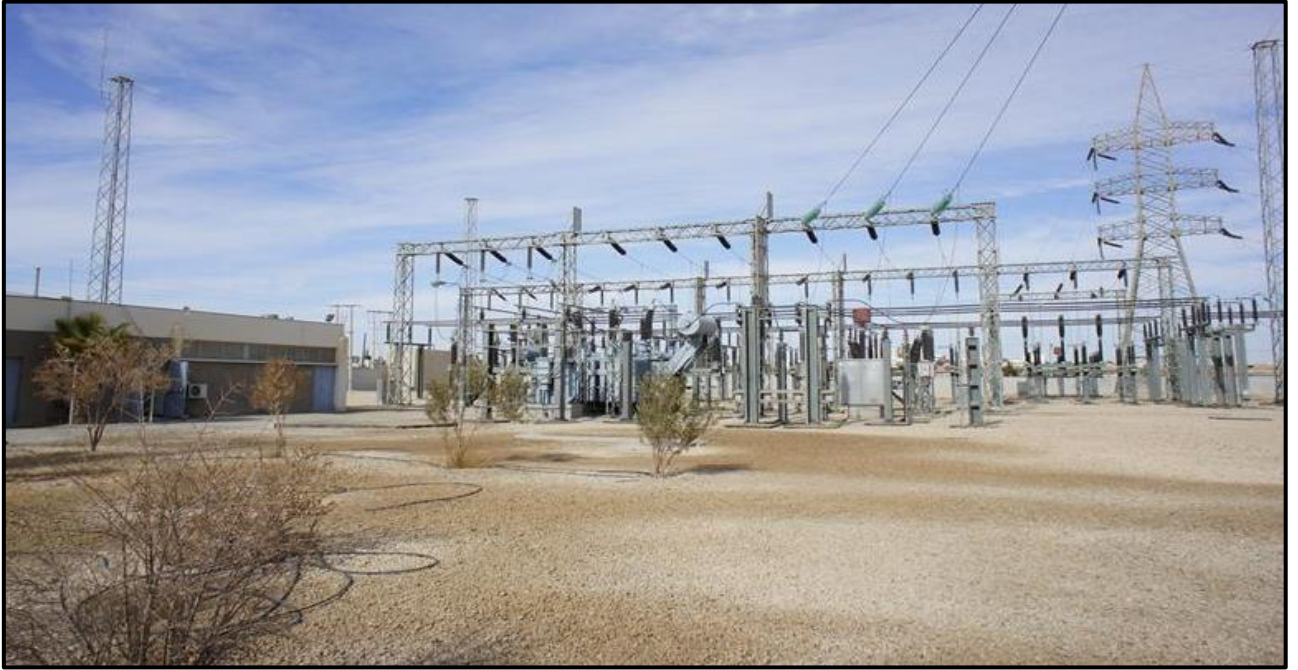
الشكل رقم 10: محطة تحويلية نموذجية بقدرة 220/33 كيلو فولت
