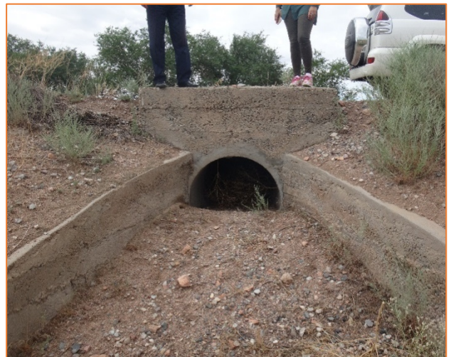
4-сурет – Типтік су өткізу құбыры
