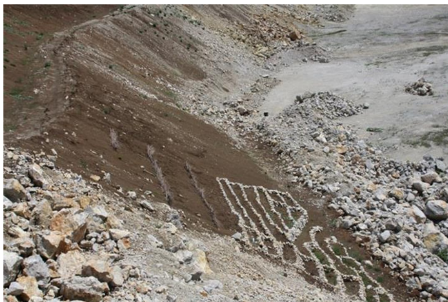
Figura 8.6 O masă de plante și material de anrocament pentru a forma terase pe o pantă abruptă
