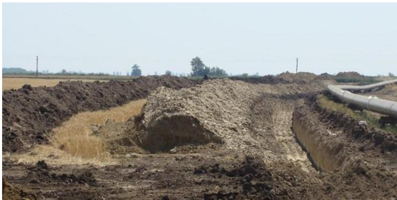
Figura 4.3 Imagine a frontului de lucru pentru amplasarea conductelor de gaz
