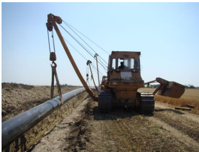
Figura 2: Lansarea unui tronson de conductă în șanț
