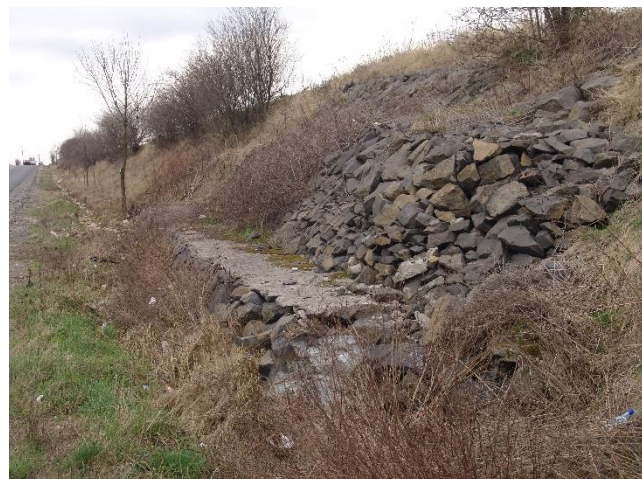
Fig. 4.II. Utilizarea de bolovănișuri ca microhabitate este în măsură a oferi nișe suplimentare ecologice (stânga) și funcționând ca zone de drenaj a apelor de spălare ce contribuie substanțial la stabilizarea pantelor (dreapta)
