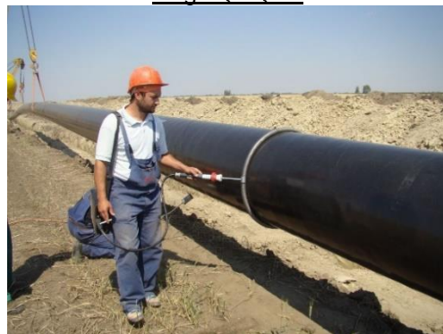
Fig.1.XIV. Verificarea izolației înaintea lansării conductei în șanț
