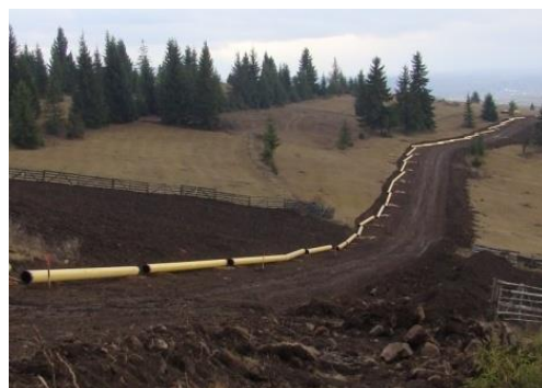
Fig.1.XIII. Segmente de țeavă înșirate în lungul șanțului
