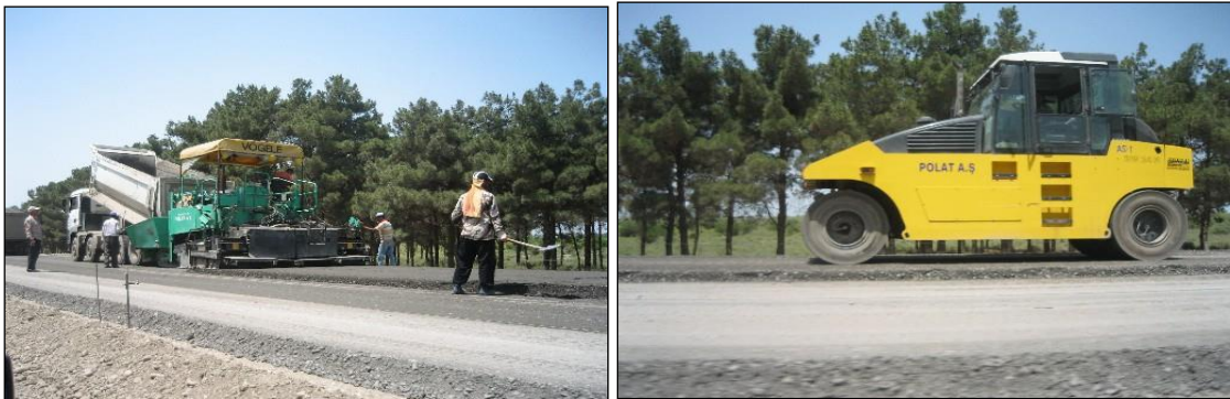
Şəkil 7: M-2 avtomobil yolu boyunca avtomobil yolun tikintisi. Sol tərəfdə asfalt döşəyən maşın, sağ tərəfdə vərdenə göstərilir.
