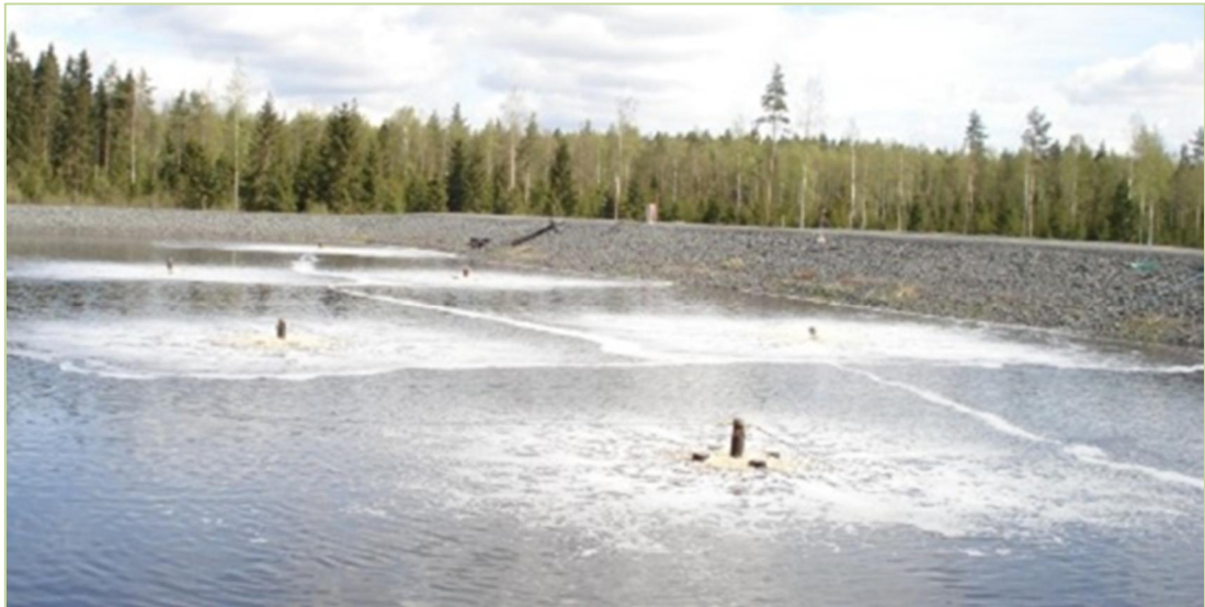
სურათი 35. ლაგუნის ხედი ზედაპირის აერატორებით რომელიც დამონტაჟებულია ჟანგმადის მომარაგებისთვის
