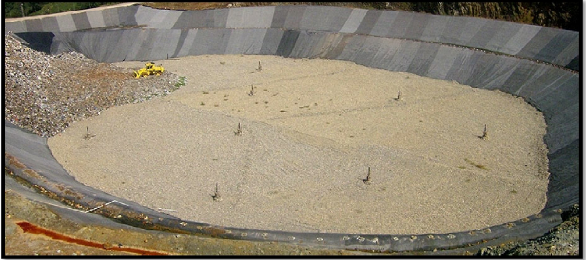
Kaynak: Mezitli Atıksu Arıtma Tesisi Kavramsal Tasarımı Dokümanı, 2013 Fotoğraf 4. Arıtma Çamurlarının Düzenli Depolama Sahalarında Depolanmasına Örnek
