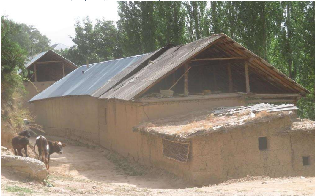
Рис.14: Каркасное/глинобитное здание в Кандаке (август 2018 г.)
