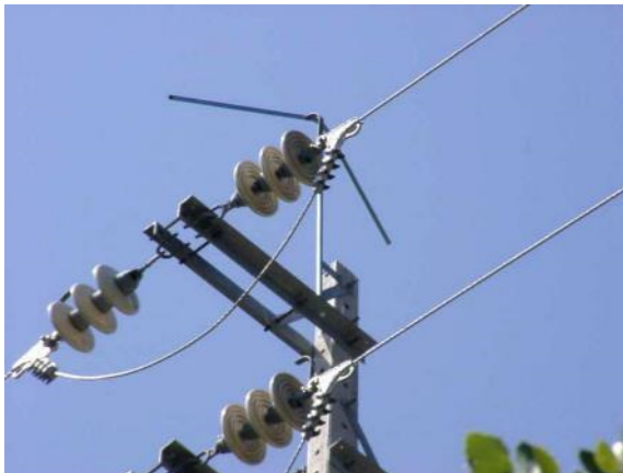
Şekil8-84. Kuş uzak tutma cihazı olarak üstünde simetrik zikzak şerite sahip dağıtım direği
