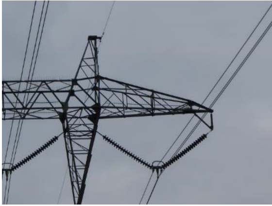
Şekil8-82 Tüneme önleyicilerle (dikenler) birlikte yeni enerji iletim hattı güzergahına paralel mevcut enerji iletim hattı
