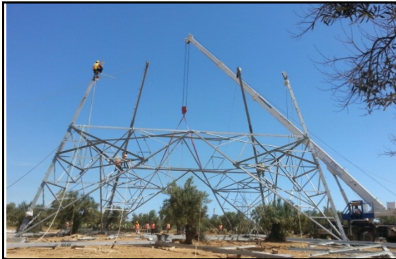
ورشة وضع أبراج الطاقة الكهربائية، الخط 400 كيلوفولط مساكين - سوسة (المصدر STEG)
