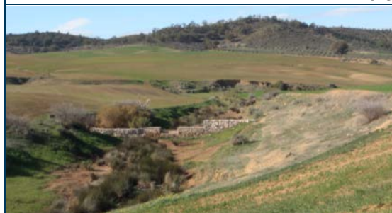
Oued stabilisé par des gabions
