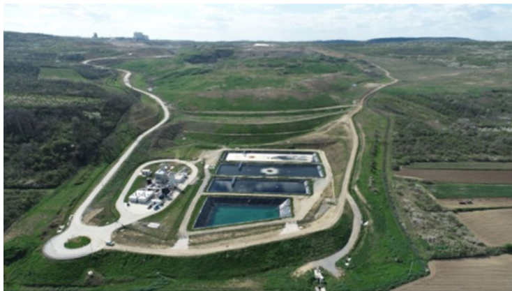
Postrojenje za prečišćavanje procednih voda na deponiji Vinča Izvor: Beo Čista Energija
