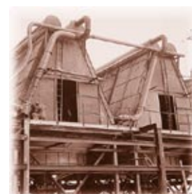
Мутновская геотермальная электростанция, Российская Федерация
