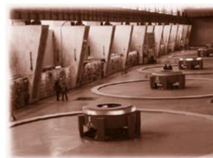
Гидроэнергетическое предприятие компании “Мосэнерго”, Российская Федерация
